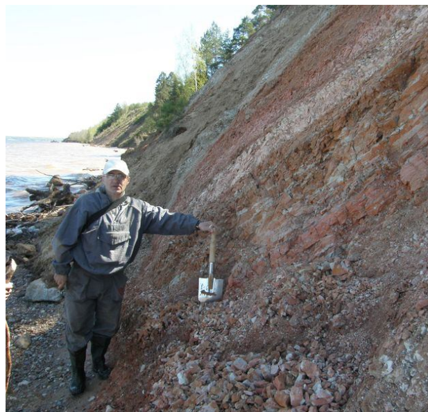
Дислокации триасовых пестроцветных глин по берегу Волги в районе г. Пучеж
